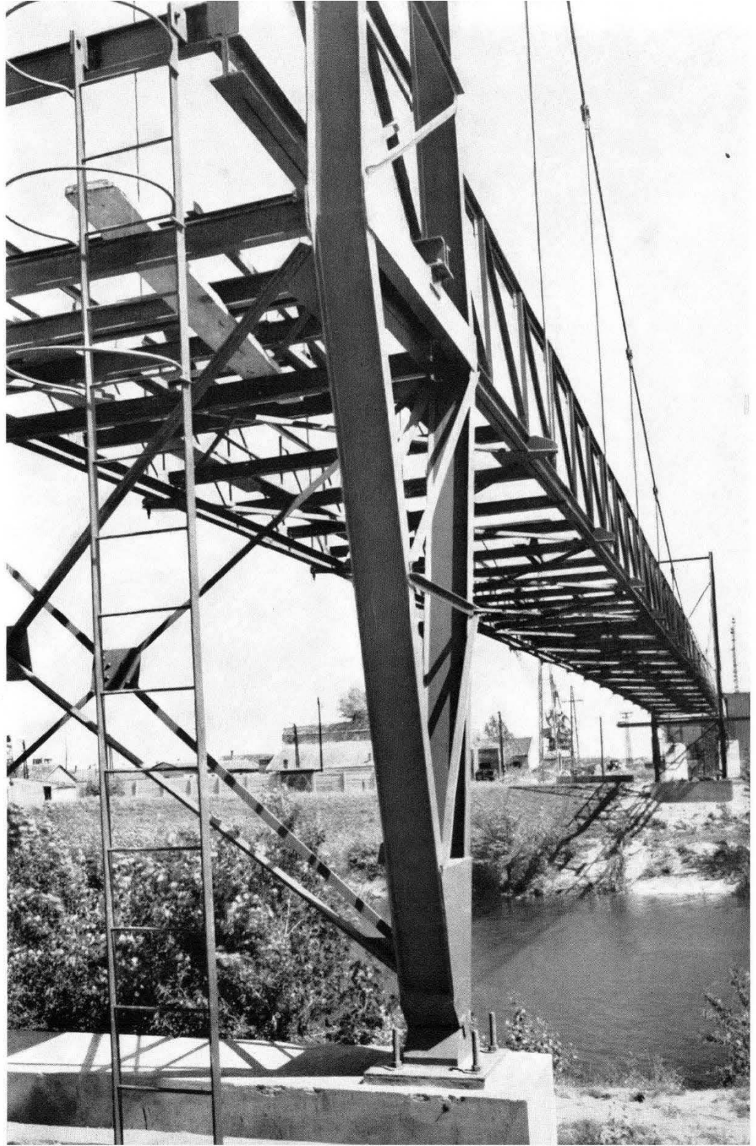
Győr, Iparcsatorna feletti kábelhíd
